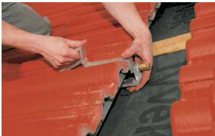
Нові дахові гаки для Solar 3000 TF, Solar 5000 TF і Solar 7000 TF – регульовані та нескладні
