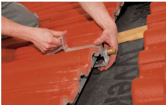
Нові дахові гаки для Solar 5000 TF and Solar 7000 TF – регульовані та нескладні
